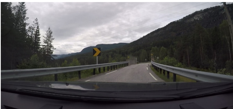
Bilde 7: Smal bru, maks bredde 3,6 meter, med bratt stigning inn til bro. Kan medføre trafikale problemer, spesielt for vogntog på vinterstid.
