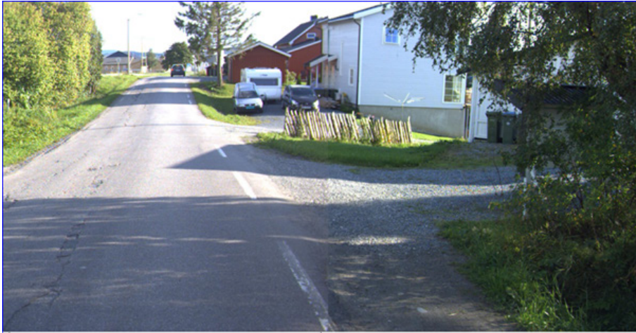
Figur 5. Start av Fv 119 som inngår som omkjøringsveg for E6 mellom Gråmyra og Holsand. Vegen er smal og bebyggelse tett på og det er mange avkjørsler. Tillatt med 19,5 meter vogntog ifølge veglisten.
