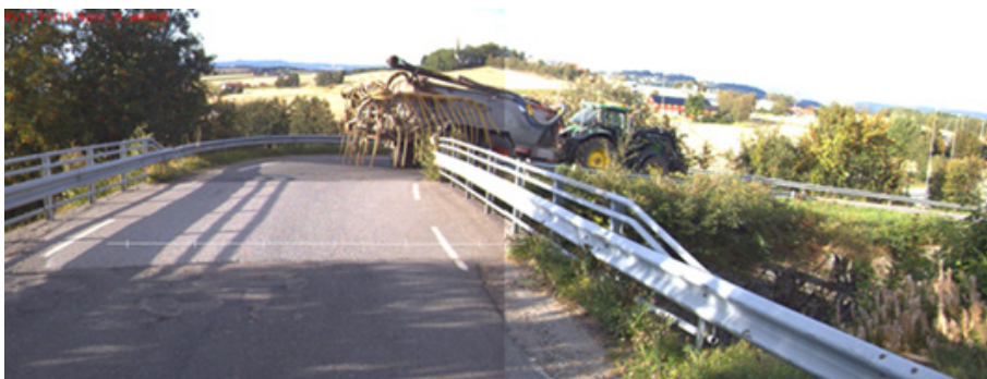
Figur 4. Smal bru med skarp kurve og stigning på Fv 119, Hp 01 Km 1,948. Denne vegen er omkjøringsrute for E6 i Nord-Trøndelag.
