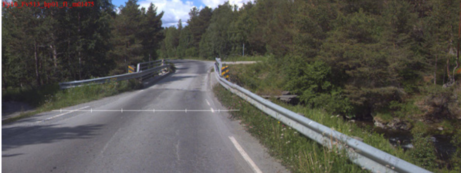
Figur 1. En av flere smale bruer på Fv 513. Smaleste bru er skiltet maks bredde 3,1 meter. Strekningen er omkjøringsveg for E6 i Sør-Trøndelag
