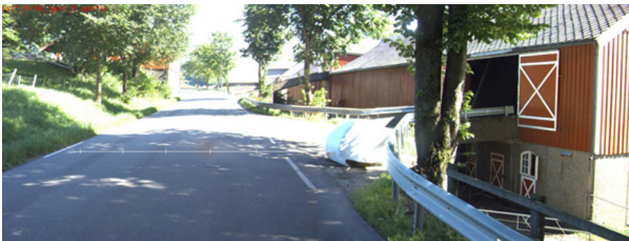
Figur 6. En smal og uoversiktlig del av Fv 763, Hp 01 km 3733, som går igjennom et gårdstun. Vegen er omkjøringsveg for E6 på stengninglenka mellom Asp og Vegset i Nord- Trøndelag.
